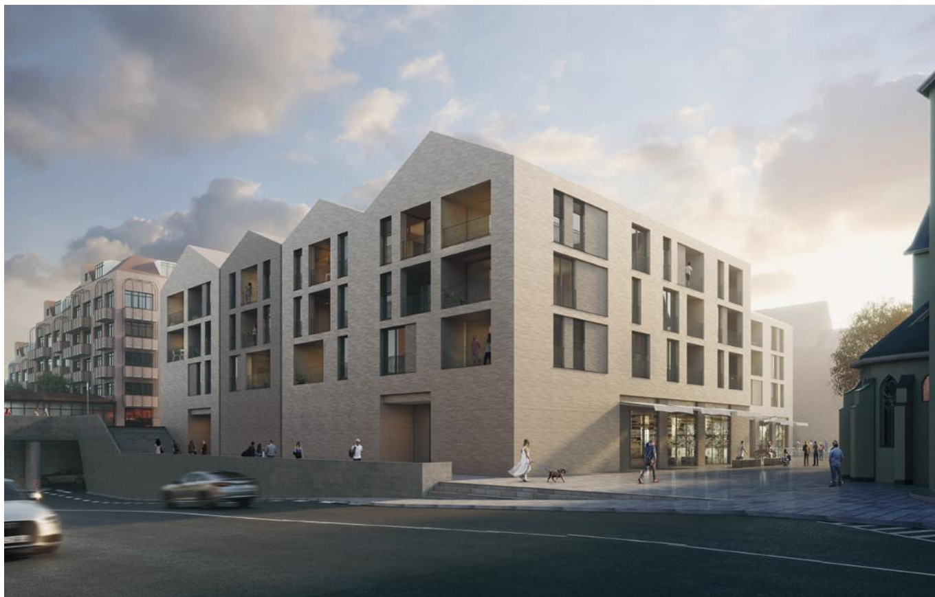
Perspektive auf Haus 1 von der Hauptstraße mit Blickrichtung Nord-Ost
