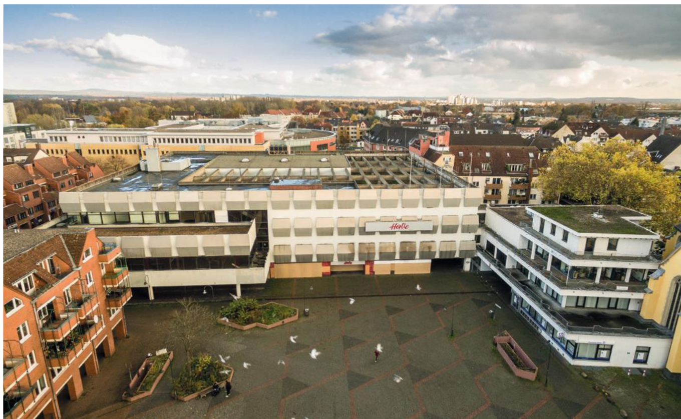
Friedrich-Ebert-Platz vor Abriss der Hertie-Immobilie, Herbst 2017
