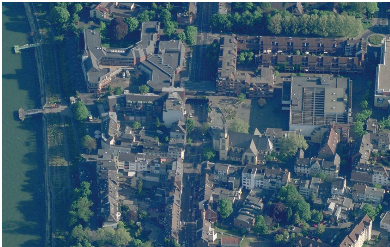
Schrägluftbild der Situation vor Abriss der Hertie-Immobilie | © Stadt Köln
