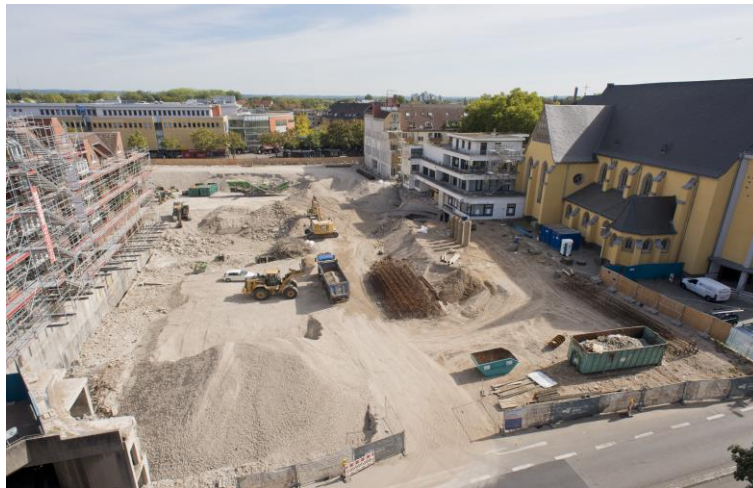
Die Baugrube der Neuen Mitte Porz im September 2018 © Daniel Poštrak
