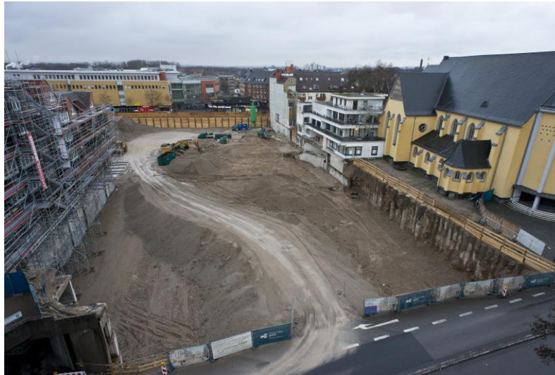
Die Erstellung der Baugrube ist abgeschlossen. © Daniel Postrak
